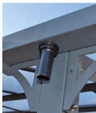
Okapy s odvodem vody
